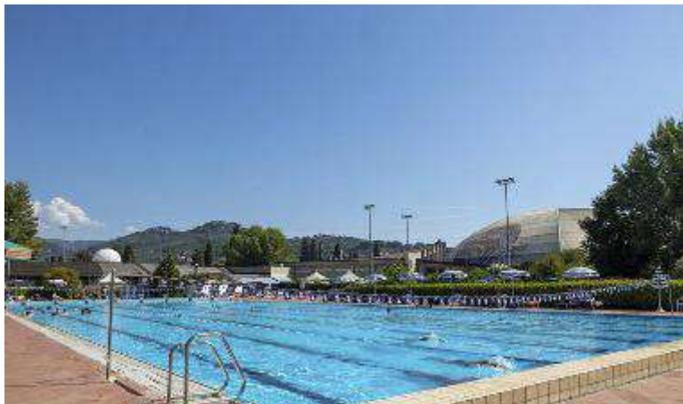
La piscina estiva sarà sottoposta a immediati lavori tampone (Goiorani)
