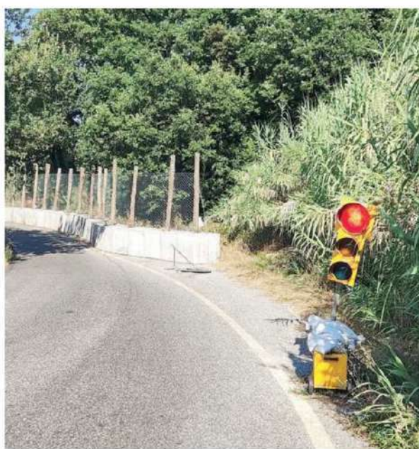
Sopra il semaforo per il senso unico alternato in via Mammianese Marlianesa
